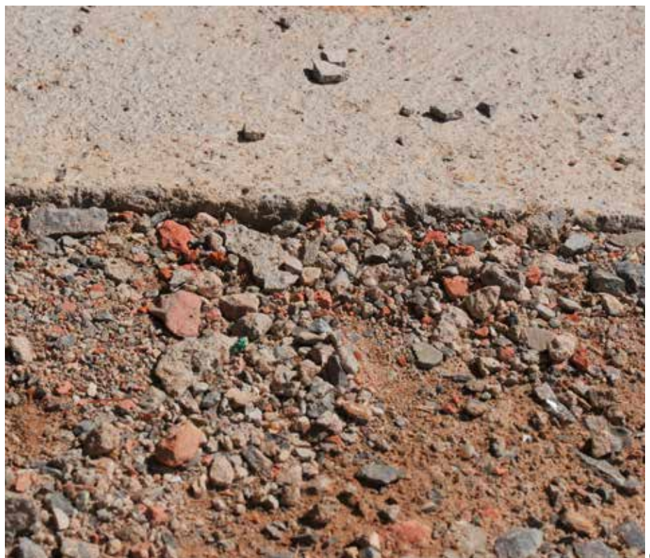
Verbautes Recyclingmaterial in einer Schottertragschicht
